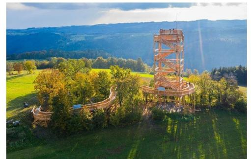
Der Turm wurde 2020 neu errichtet. Höhe: 26 m, Aussichtsplattform: 6 m x 4 m, Stufenanzahl: 103, Baumaterial: 5.500 kg Stahl, 7.000 Stk. Schrauben und Bolzen, 100 m<sup>3</sup> Holz, Baukosten: € 330.000,00 davon 60 % EU-Leader Förderung, Bauausführung und Planung: Fa. Resch aus Ulrichsberg
